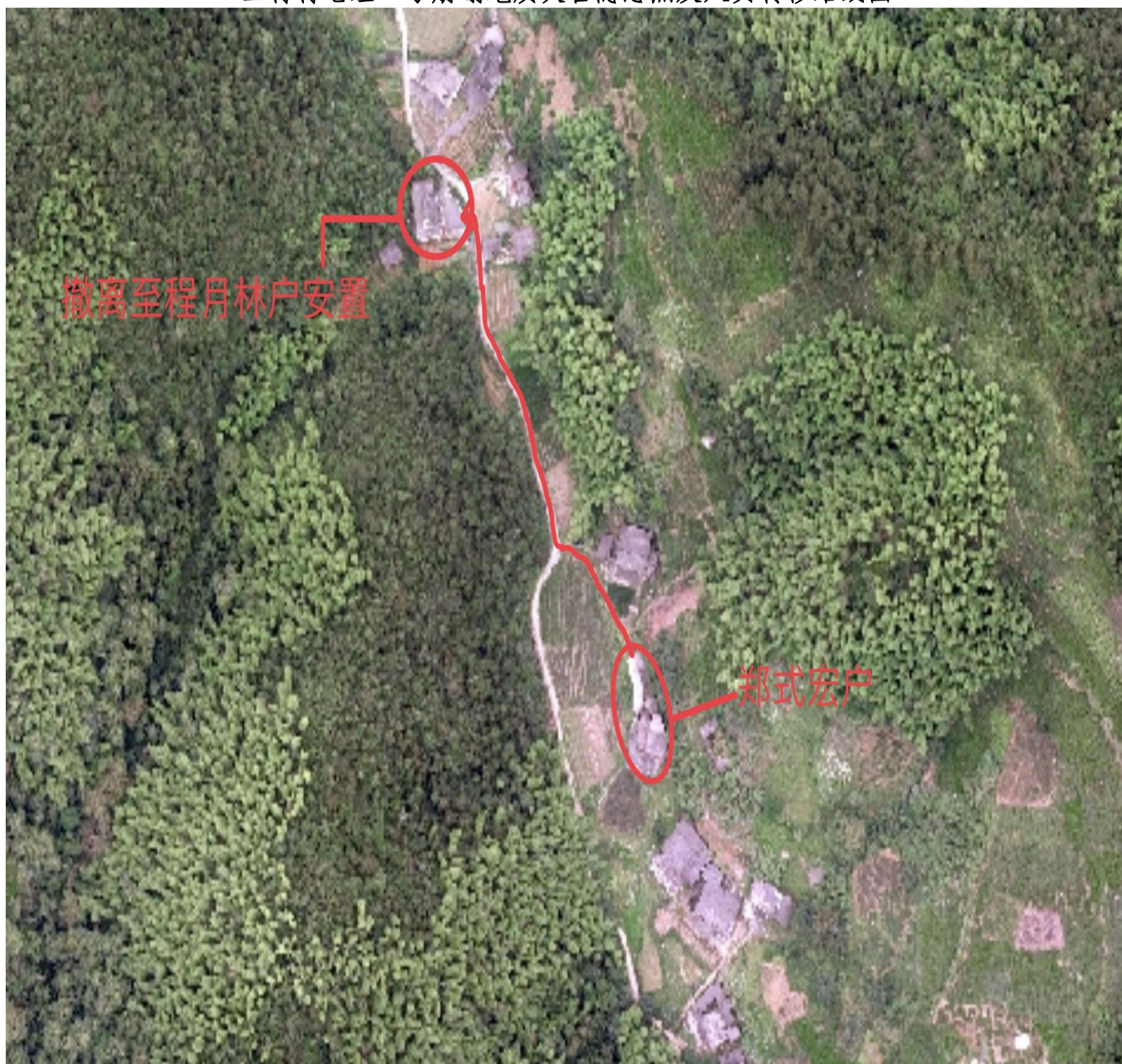
三村村七组二号崩塌地质灾害隐患点及人员转移路线图
